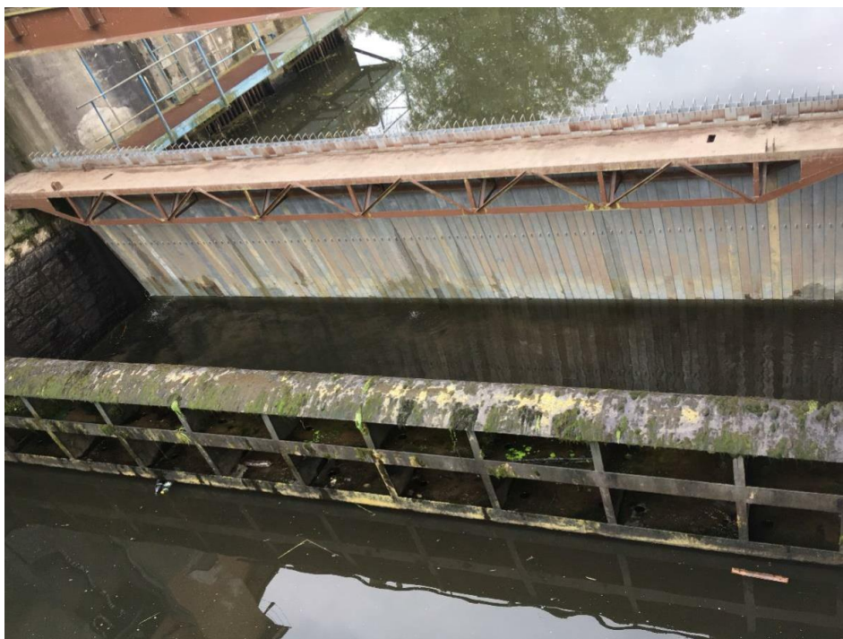
Realizované zahrazení z horní vody – pohled z mezilipře (foto: Potápěčská stanice, a.s., Praha)
