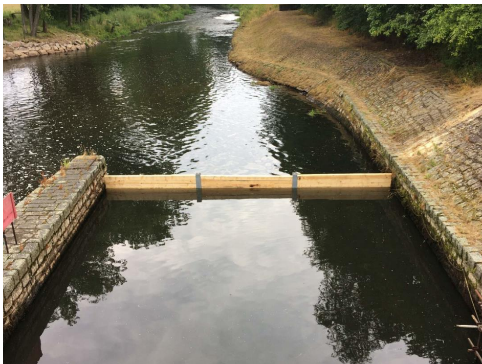
Realizované zahrazení z dolní vody – pohled z lávky (foto: Potápěčská stanice, a.s., Praha)
