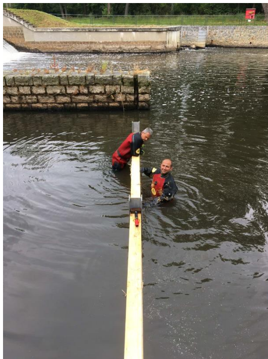
Osazování hradidel dolního provizorního hrazení – pohled z pravého břehu (foto: Potápěčská stanice, a.s., Praha)
