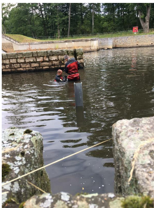
Osazování slupic dolního provizorního hrazení – pohled z pravého břehu (foto: Potápěčská stanice, a.s., Praha)
