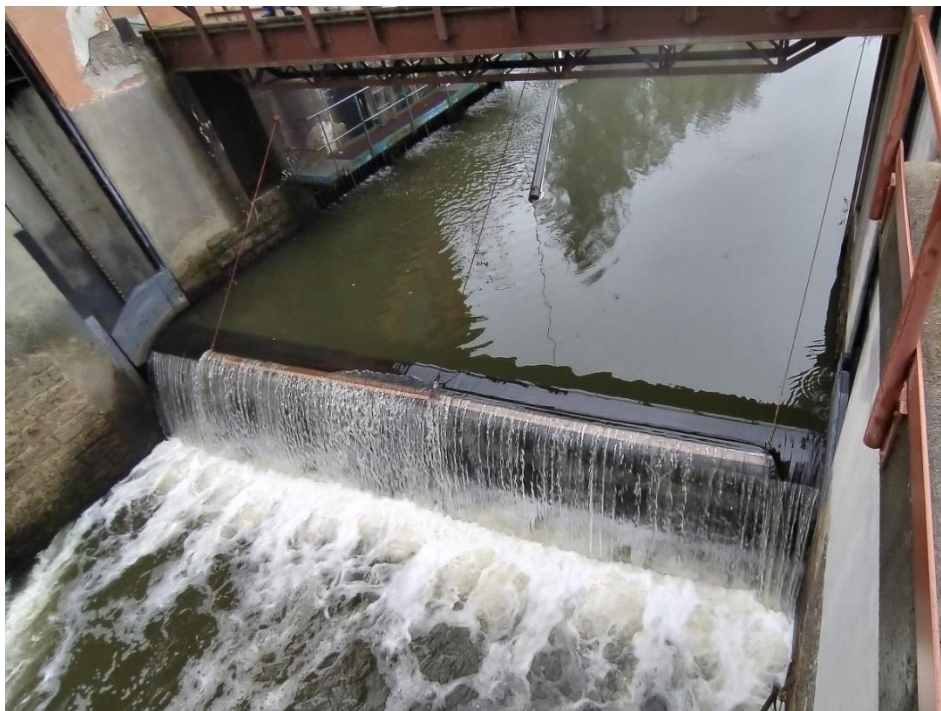
Protivodní pohled na stavidlový uzávěr z mezpilíře – s přepadající vodou
