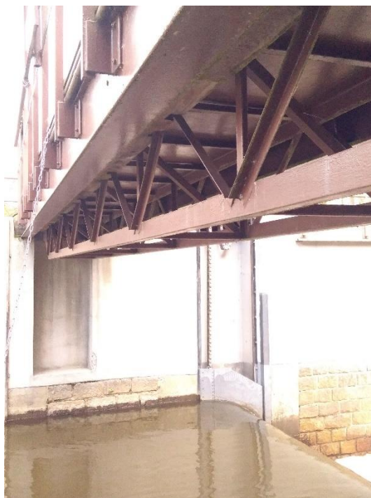
Pohled na v lávce zavěšený příhradový nosník horního provizorního hrazení
