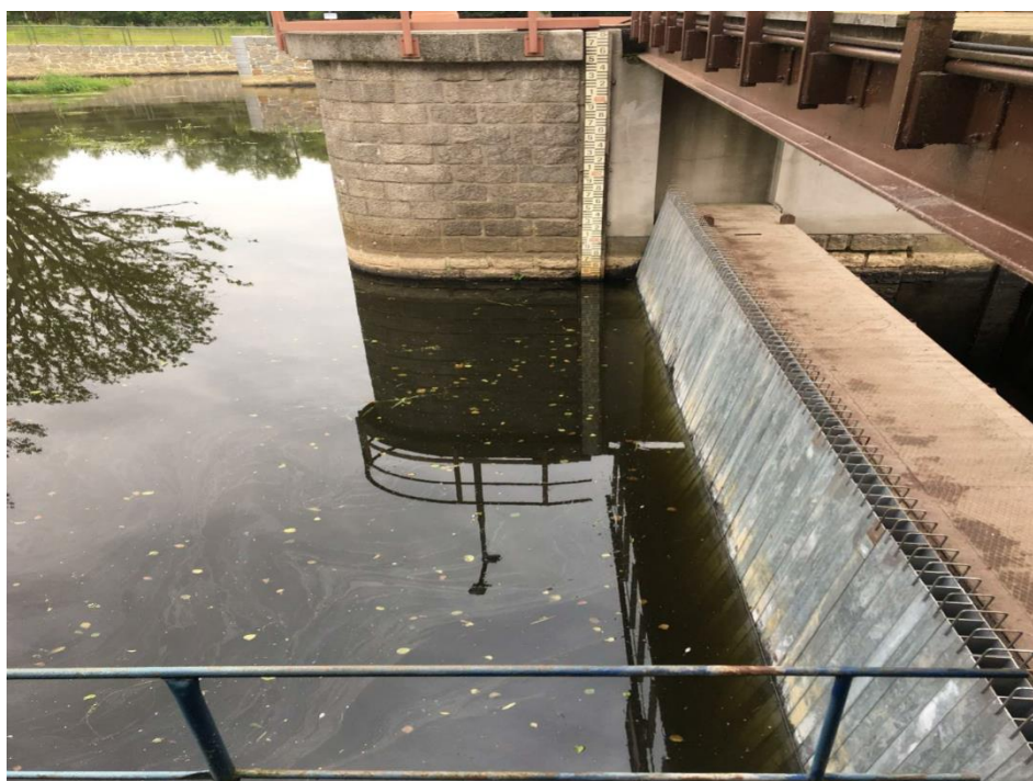
Realizované zahrazení z horní vody – pohled z pravého břehu (foto: Potápěčská stanice, a.s., Praha)
