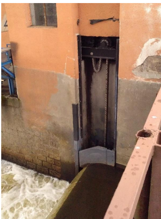
Pohled z lávky na drážku stavidla na provozním domku
