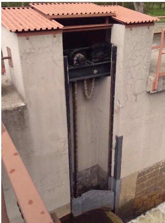
Pohled z lávky na drážku stavidla v mezpilíři
